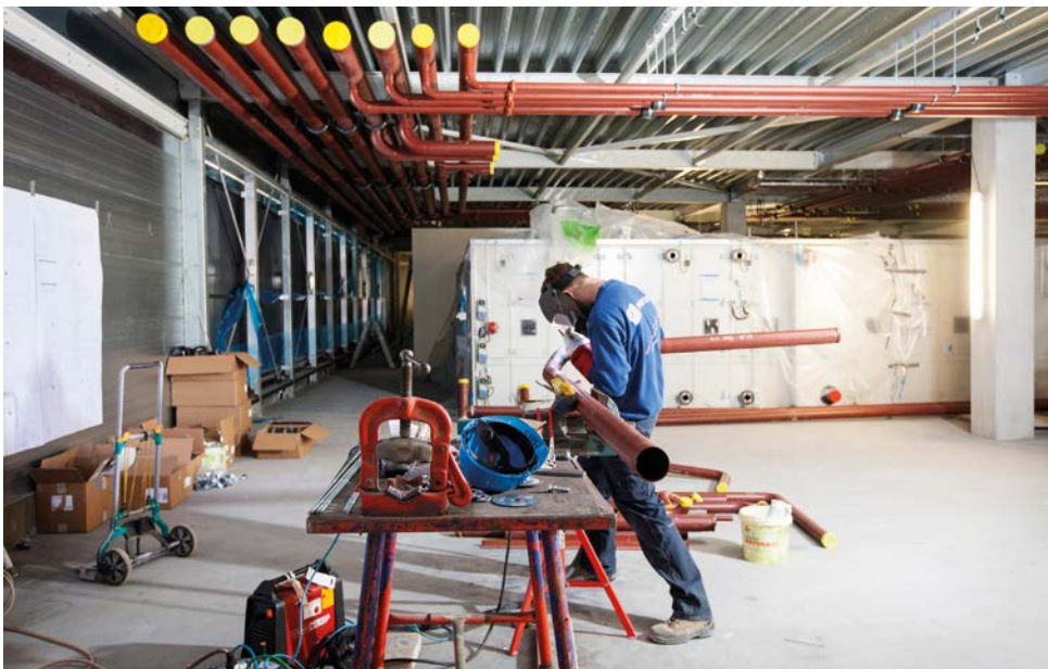
Bouw in uitvoering.
